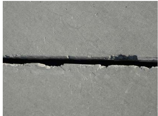
15mm スリット側溝欠け・割れ状況
