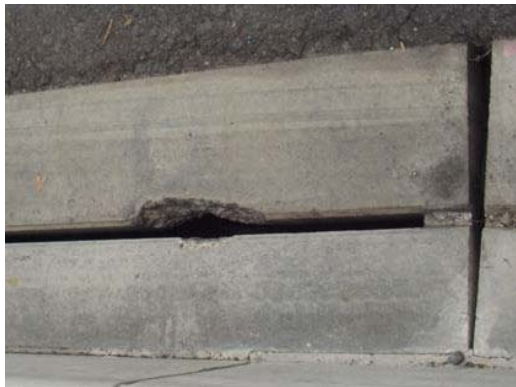
15mm スリット側溝欠け・割れ状況
