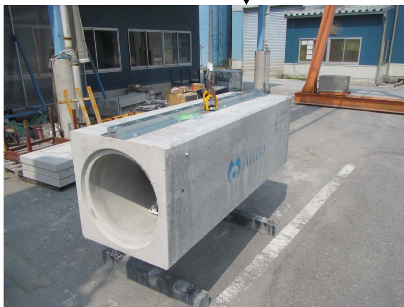
敷設後、座金+M16 ボルトを締め付ける
