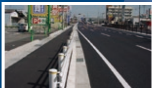
2 国道258号 大桑道路
