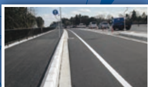
4 国道23号 中勢道路
