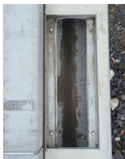
1. グレーチングを外す
