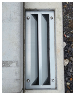
2. ポーソー板を設置
