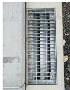
3. グレーチングを設置
