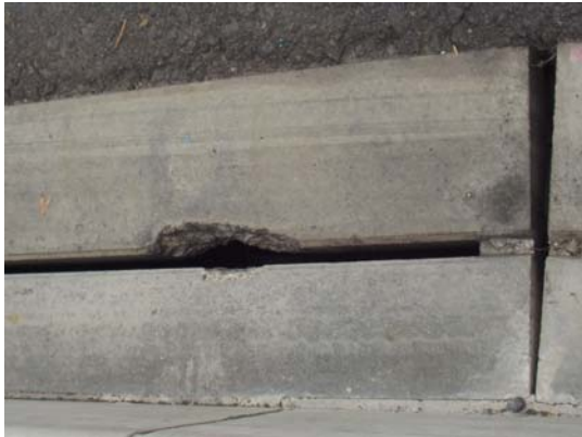
15mm スリット側溝欠け・割れ状況
