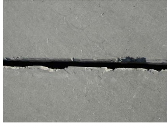
15mm スリット側溝欠け・割れ状況
