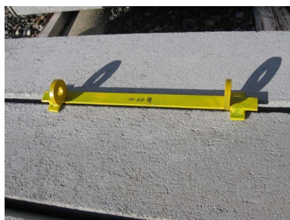
④廻り止め金具をセットします
