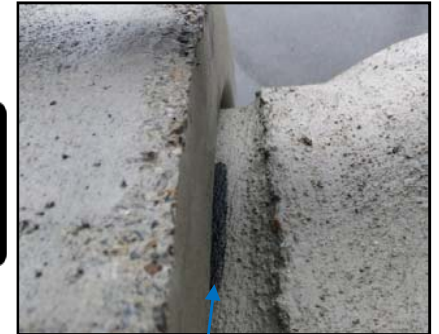
④メス端部が差し込み限界線の中に 収まれば完了です
