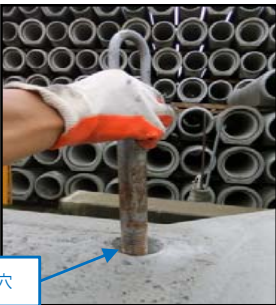
①引込用金具を差し込み ナットで固定する
